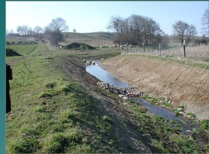
Entrohrung eines Fließgewässers
