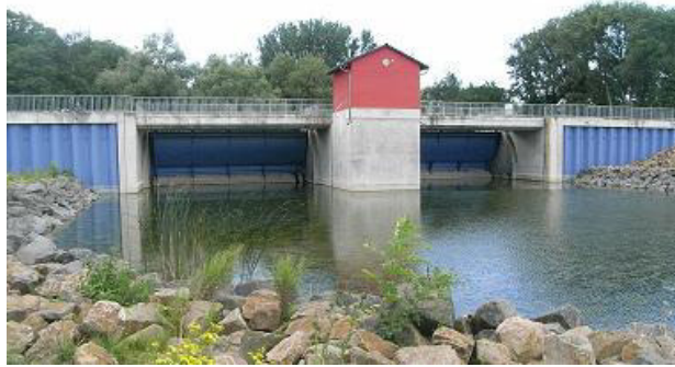
Abbildung 50: Ein- und Auslassbauwerk Polder Ingelheim
