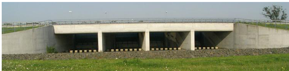
Abbildung 39: Ein- und Auslassbauwerk Polder Bodenheim/Laubenheim
