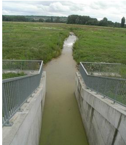
Abbildung 49: Einlauf in die ökologische Flutungsfläche
