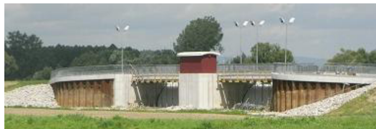
Abbildung 62: Ein- und Auslassbauwerk HWR Wörth-Jockgrim
