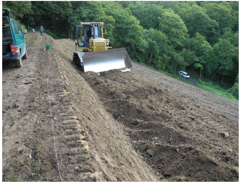
Abb. 18: Einebnen der Terrassenplattform mit Hilfe der Planierraupe
