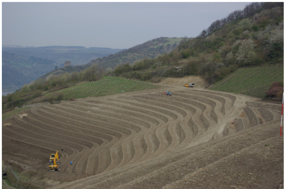
Abb. 50: Bau der Querterrassen mit Planierdraupe und Bagger in der obersten Tafel
