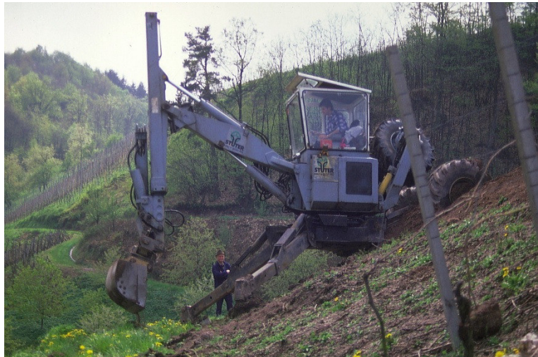
Abb. 15: Menzi-Muck beim Terrassenbau
