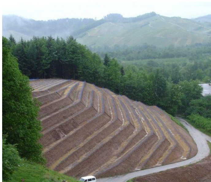
Abb. 21: Terrassen mit sehr starker Innenneigung, das Wasser „steht“ am Böschungsfuß
