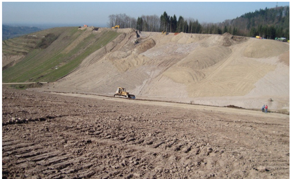
Abb. 34: Westseite während der Planiearbei- ten
