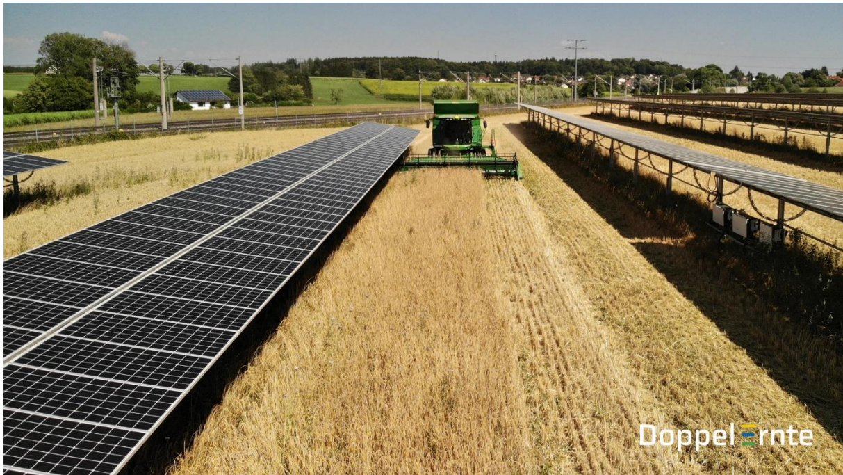
Abb. 3: Einblick in die Agri-PVA in der Gemeinde Althegnenberg (Landkreis Fürstenfeldbruck) auf rd. 4,5 ha Projektfläche. Die Fläche bleibt zu über 90 % nutzbar. Das einachsige Trackersystem richtet die Module im Laufe des Tages der Sonne folgend von Ost nach West aus und kann sie zur Bewirtschaftung der Felder senkrecht stellen. (Foto: DoppelErnte GmbH, Mering)
