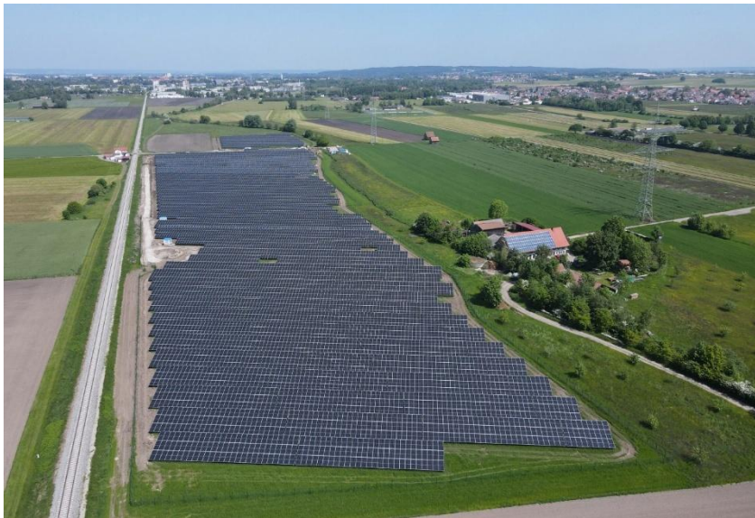
Abb. 1: Solarpark Benningen (LK Unterallgäu) entlang der Bahnlinie Ulm-Kempten auf rund 9 ha Fläche mit insg. 17.280 Modulen und einer Stromproduktion von rund 10,5 GW pro Jahr, seit August 2023 auf Basis eines Bebauungsplans der Gemeinde Benningen in Betrieb (Foto: VenSol Neue Energien GmbH 2026)
