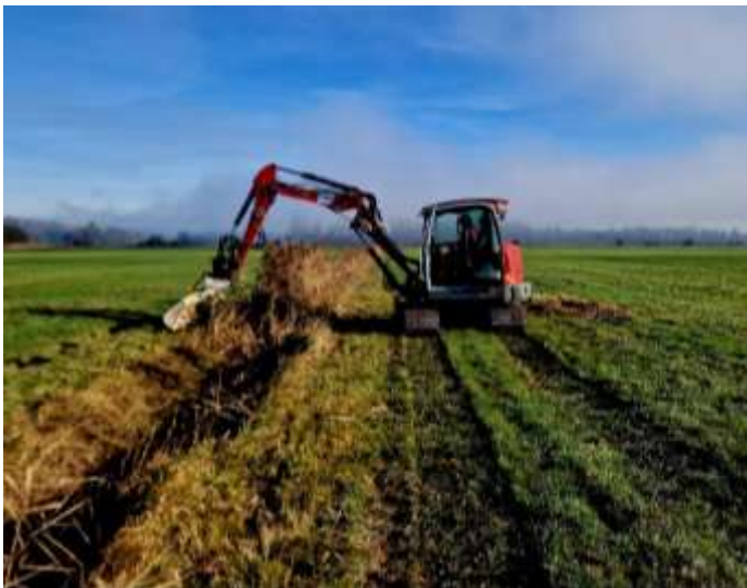
Arbeiten am Graben 18 mit einem Mähkorb im September 2025
