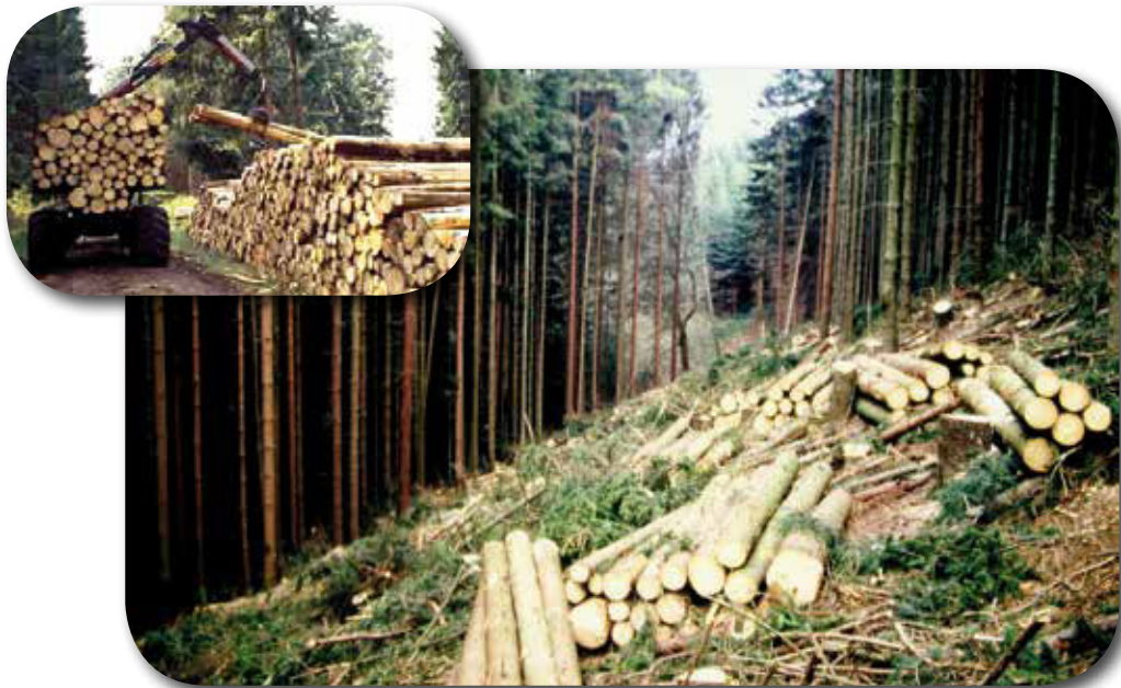
Abb. 9 u. 10: Ein wesentlicher Strukturangel im Wald ist die unzureichende Erschließung. Das Beispiel aus Rheinland-Pfalz zeigt die vorbereitenden Arbeiten für die Herstellung eines neuen Wirtschaftsweges.
