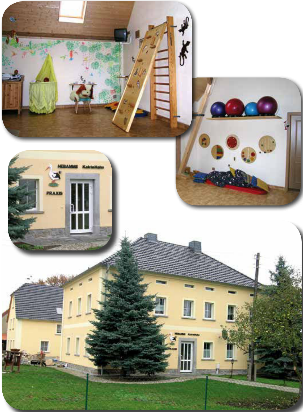
Abb. 11: In Pließkowitz (Sachsen) wurde eine Hebammenpraxis und Ergotherapie auf behutsame Weise in die ländliche Baussubstanz integriert. Durch die Sanierung und Umgestaltung des Nebengebäudes konnte die Struktur eines Dreiseithofes erhalten werden.
